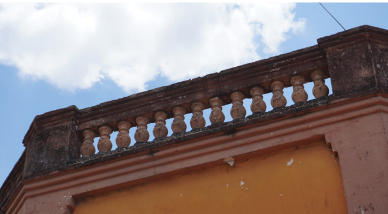
Cornisa del edificio de la “Escuela de cerámica Centro Cultural Maqueda”. Se observan las balaustradas de coronamiento con diseños de ángeles integrados (2025).
