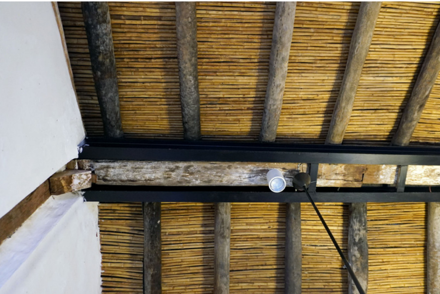
Detalle de la cubierta restaurada de la casa Bibolini Veia, parte del conjunto de viviendas en galería, al costado de la Iglesia de la Candelaria. Se observan los elementos estructurales originales conservados: Tacuarillas con tirantes en caranda'y; con soporte estructural metalico de refuerzo en la viga principal. Igualmente se observa la estructura del pilar de madera embebido dentro de la pared, a la usanza del método constructivo de fines del siglo XIX. (2025)
