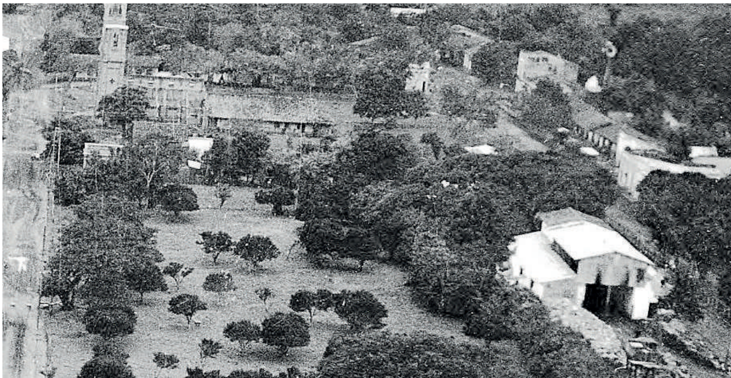
Fig.14: Vista aérea donde se observan los talleres de la antigua Estación del Tren (derecha). Podemos identificar de fondo algunas de las primeras edificaciones de la ciudad y la Catedral. Fotografía de Robert Plat-1930. Cortesía Silvio Ávalos Sánchez
