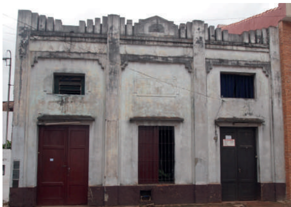
Fachada sobre línea municipal
