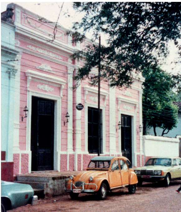
Fachadas de la edificación, año 1980 - Isanne Gayet
