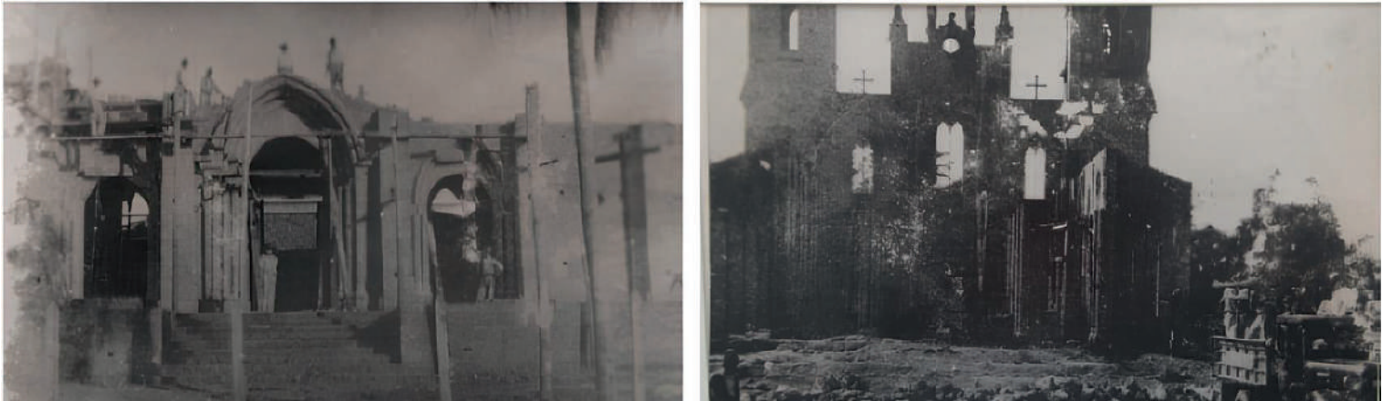
Figura 16 y 17: Imágenes del proceso de edificación que duro medio siglo Centro de Convergencia Cultural de San Lorenzo- Sr. Silvio Ávalos Sánchez.
