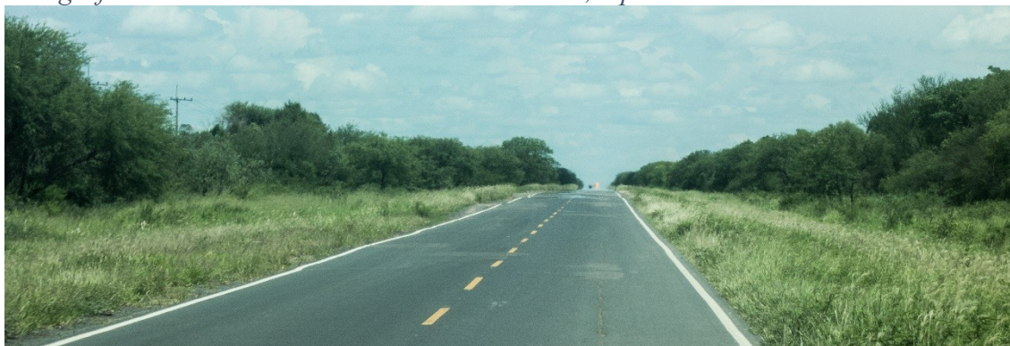
Fotografía 1. La ruta Transchaco en la actualidad, a proximidad del Chaco Central
